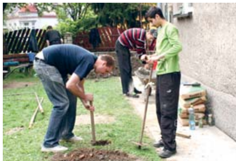
Kluci z SŠTaS se spolu s ředitelem Suchánkem ujali i usazení konstrukce věšáku na prádlo.
