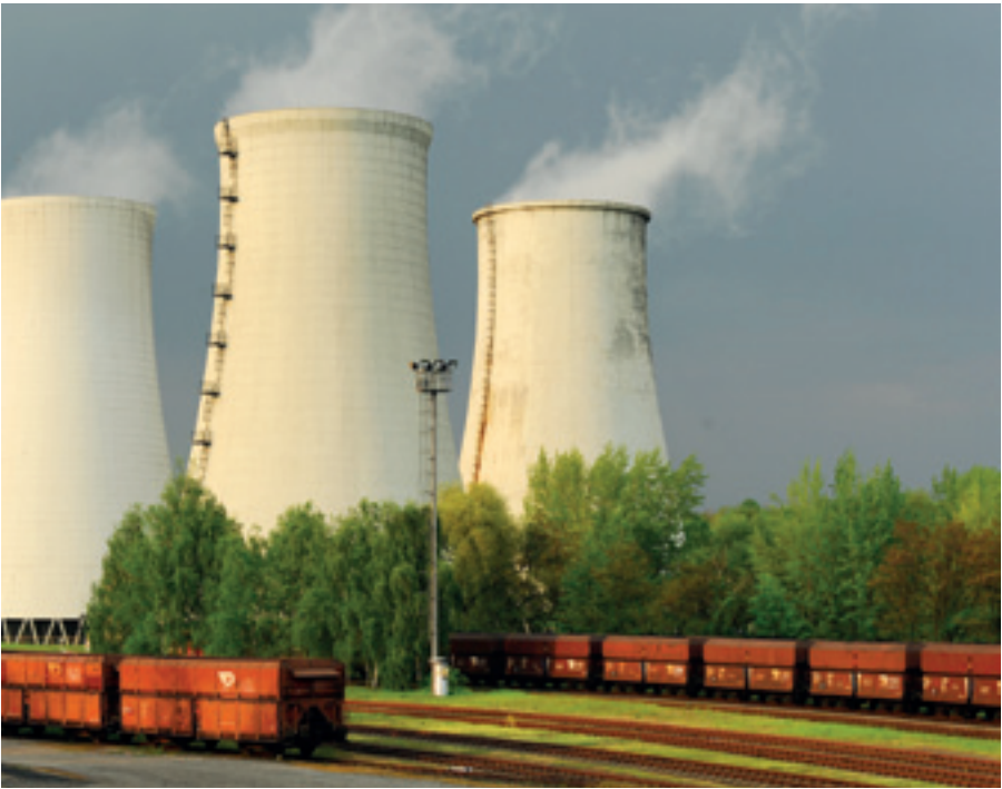
Chladicí věže teplárny Dalkia.
