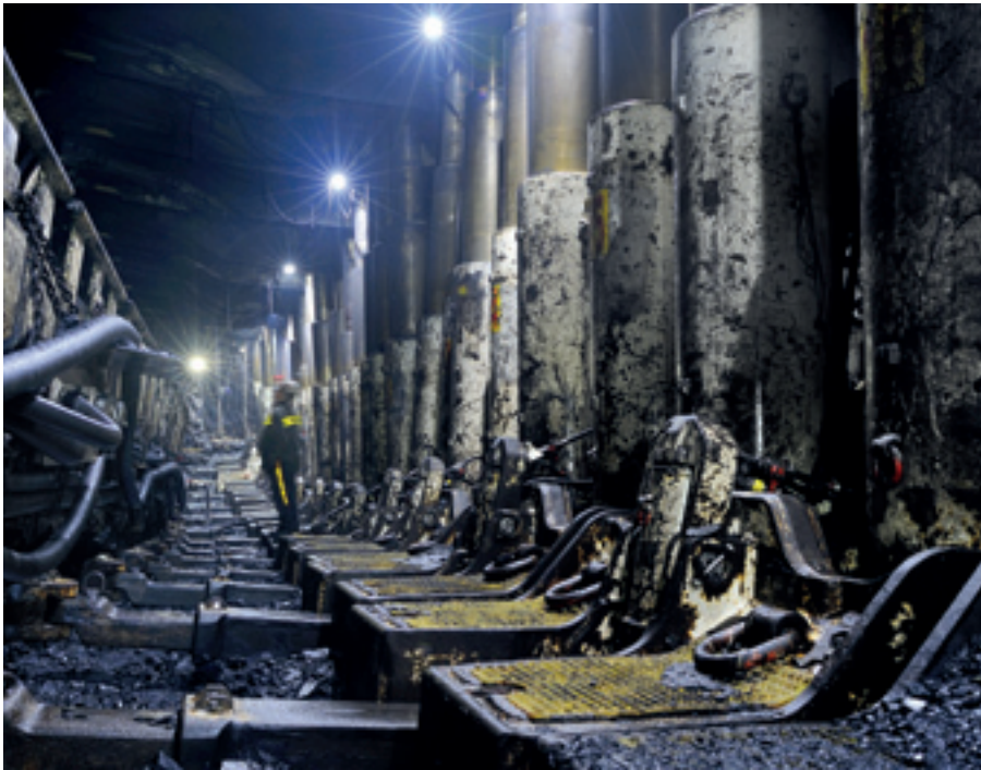
Mechanizované výztuže v závodu Lazy Dolu Karviná zakoupené v rámci programu POP 2010.
