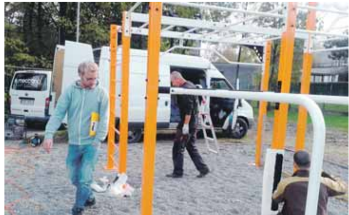
Na rozdíl od Karviné mají v Orlové všechno na jedné konstrukci.
