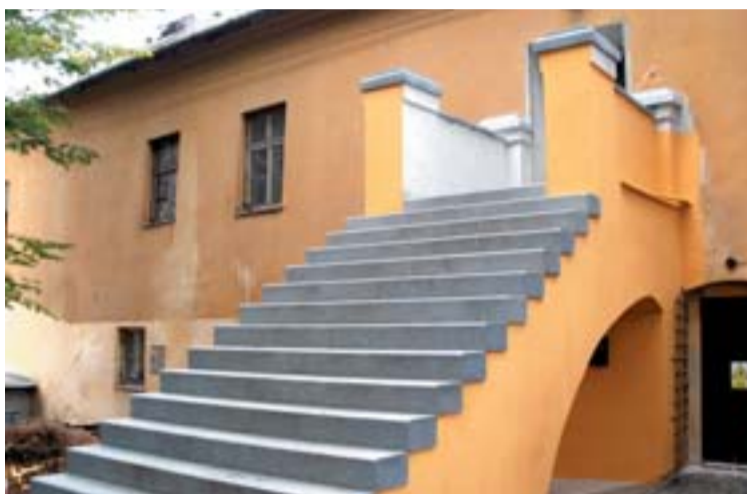
Nebýt Nadace OKD, jezdkovický zámek by takové schodiště neměl...
