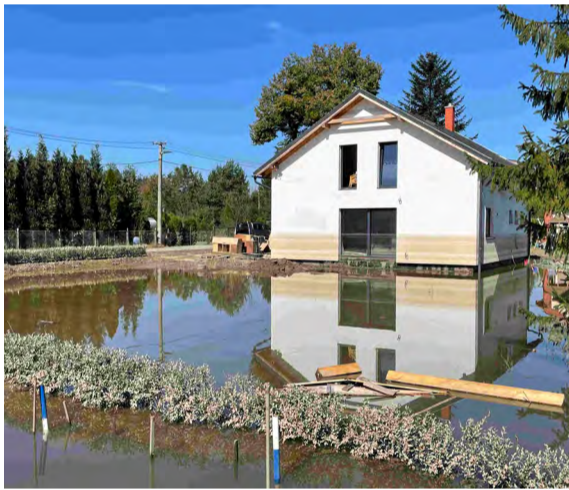
Po opadnutí vody mezi Šunychlem a Kopytovem.
