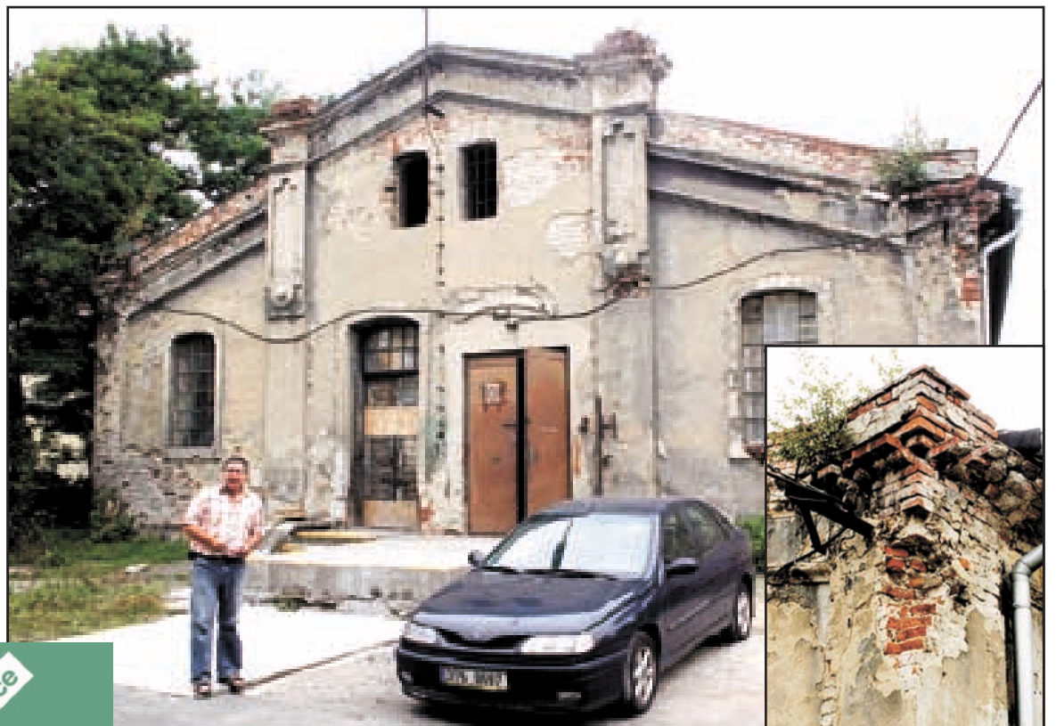
Oprava někdejší kočárovny je kvůli jejímu stavu odvážným podnikem.
